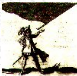
FIG. 13. DELLO SCAGLIARE L'INSEGNA NEL PASSAGGIO PER CANGIAR DI MANO
